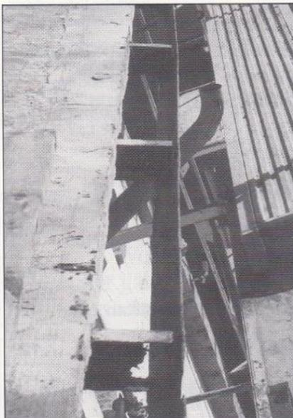
*Blick auf die Eisenträger des Betondaches, auf die die Bretter geschraubt werden.*
